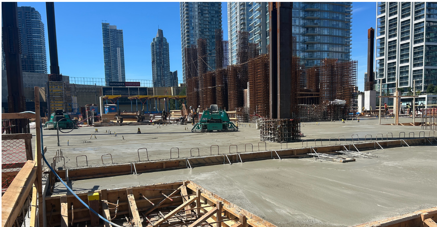
July 30, 2026: Concrete pour of level 4 slab.
